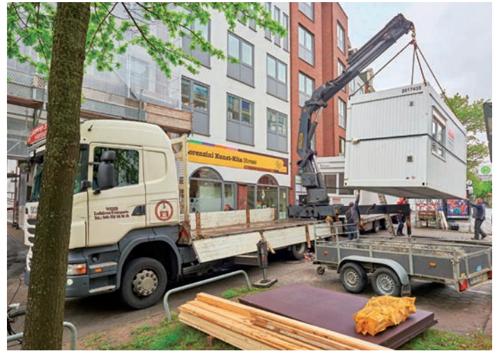
Anlieferung des Infektpraxis-Containers für die Notfallpraxis Altona
