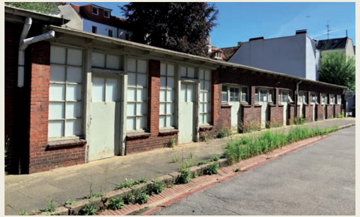
Abb. 5: Tierställe mit unterschiedlichen Frontverglasungen, deren Fenster teilweise zugestrichen wurden, um die Tiere nicht zu stark der Sonne auszusetzen
