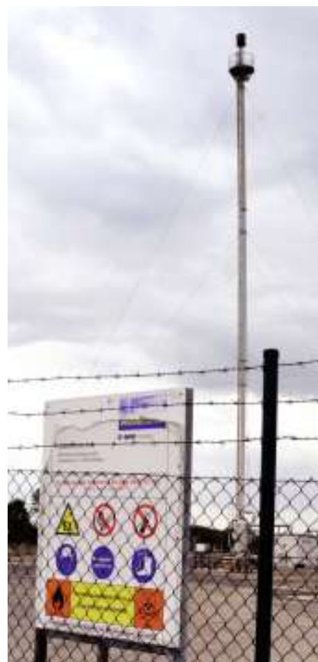
Die Bohrungen bei Staffhorst im Landkreis Diepholz in Niedersachsen wurden insgesamt siebenmal gefrackt. Wegen des hohen Schwefelgehaltes des hier geförderten Gases ist dabei die Gasfackel besonders hoch, sodass sich Verbrennungsprodukte weit übers Land verteilen konnten. Seit dem ersten Einsatz des Fracking-Verfahrens in den 1950er-Jahren wurde Deutschland mehr als 400-mal gefrackt. An der Spitze steht laut „Spiegel“ das Unternehmen ExxonMobil mit 180 Einsätzen. Die meisten Bohrungen fanden in Niedersachsen statt, wo sich die größten Erdgasvorkommen befinden
