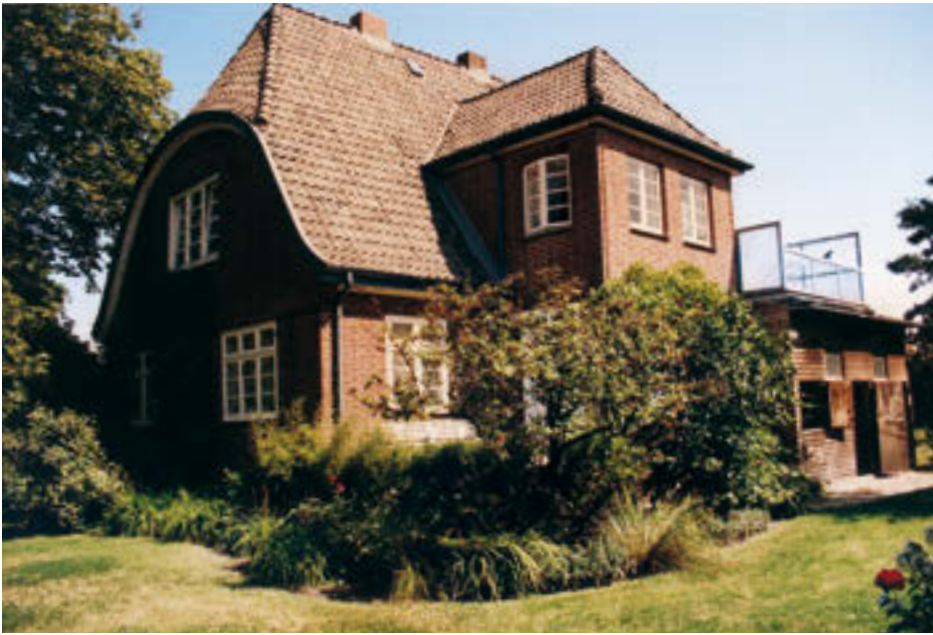
Wohnhaus mit Arztpraxis in Neuenfelde
